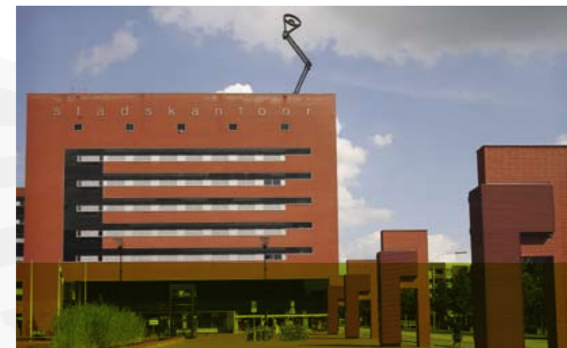
Het moderne stadskantoor aan het Lübeckplein, waar de gemeente Zwolle o.a. haar geo-informatie beheert.
